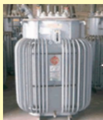
高圧トランス (変圧器)
