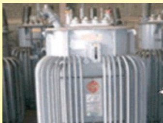
高圧トランス(変圧器)
